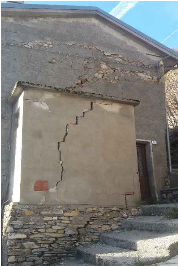
Edificio 3 deformazione del muro e dell'apertura sulla facciata est
