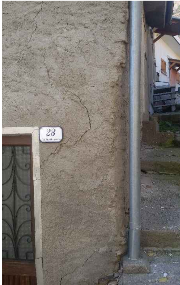
Edificio 3 deformazione del muro e dell'apertura sulla facciata est
