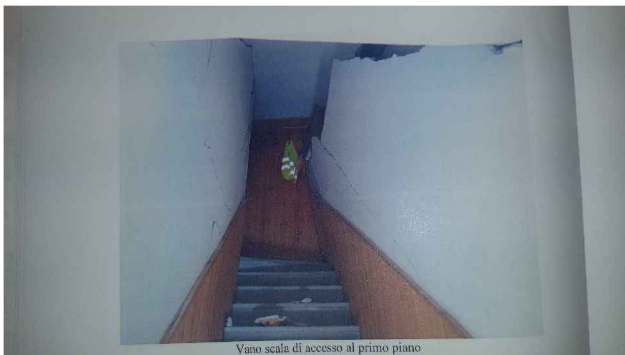
Interno edificio 1 scala di accesso al piano primo, si noti l'imponente deformazione del muro di spina sulla destra della foto
