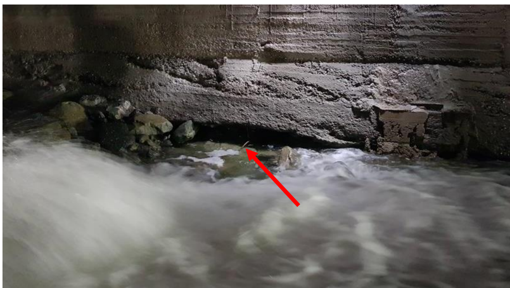
Immagine 4: torrente Armella, scalzamenti nel tratto tombinato sotto P.zza della Libertà
