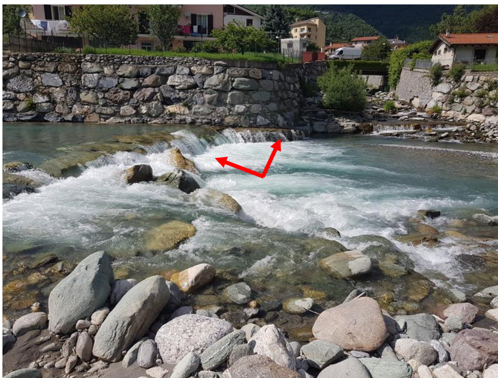
Immagine 10: torrente Armella – confluenza con il fiume Tanaro – riprofilatura alveo Tanaro, sottomurazione scogliera e movimentazione materiale in deposito
