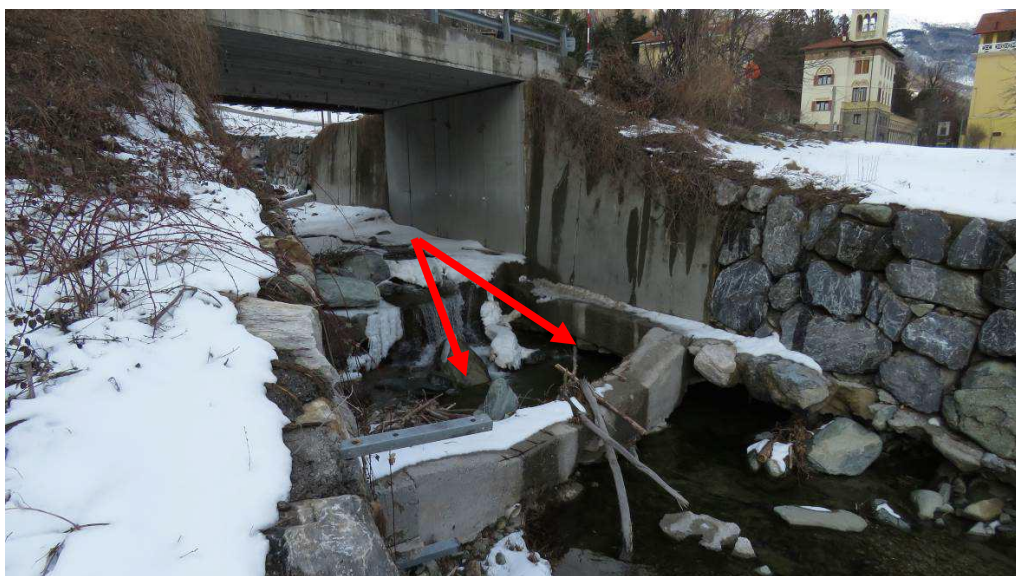
Immagine 8: rio Chiappino – tratto a valle del ponte sulla S.S. n.28 difese da sottomurare e soglia anti-scalzamento da ricostruire
