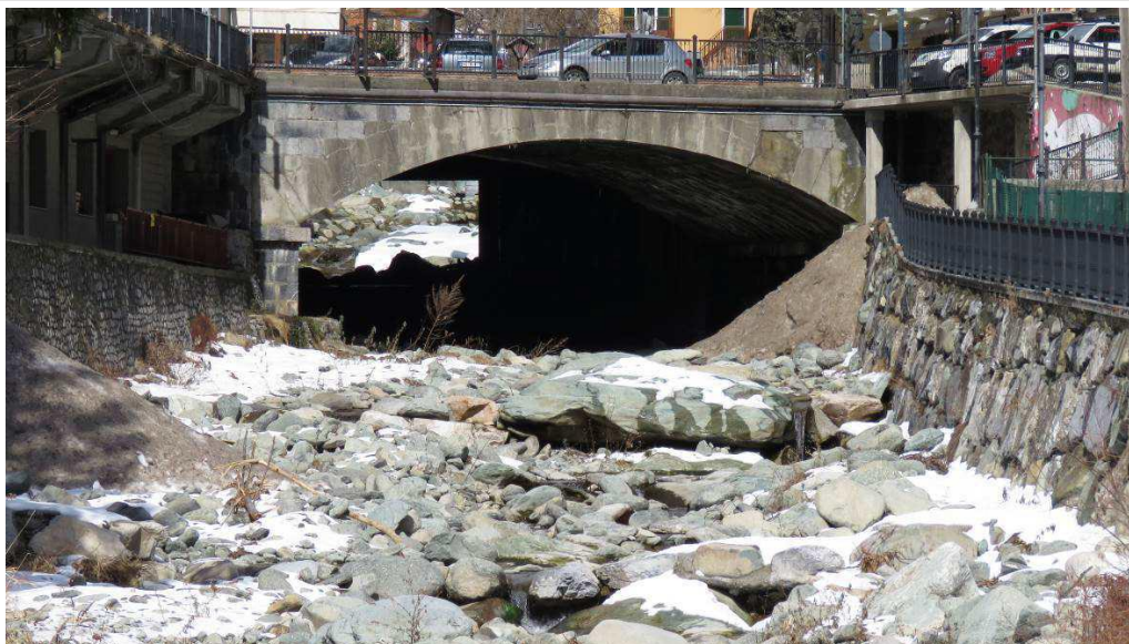
Immagine 3: torrente Armella, sbocco tratto tombinato sotto P.zza della Libertà
