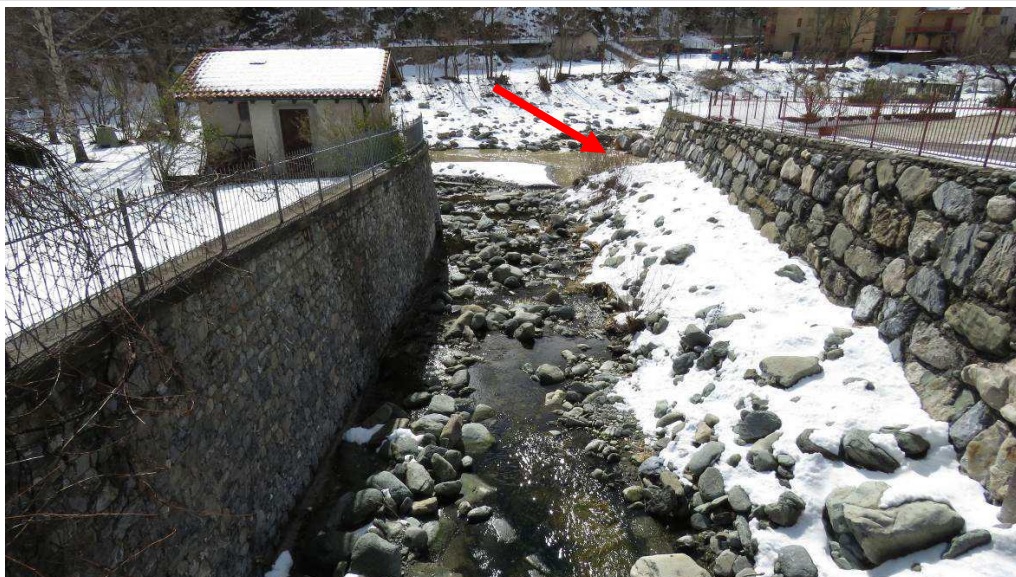
Immagine 9: torrente Armella – confluenza con il fiume Tanaro – riprofilatura alveo Tanaro, sottomurazione scogliera e movimentazione materiale in deposito
