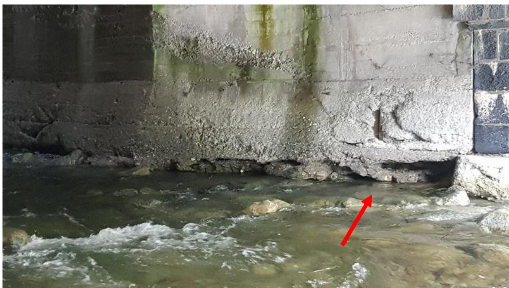
Immagine 5: torrente Armella, scalzamenti nel tratto tombinato sotto P.zza della Libertà
